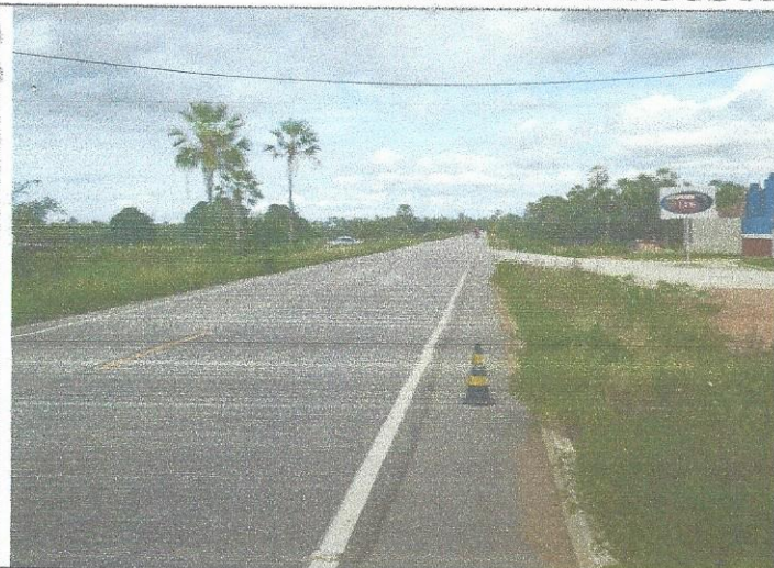
Foto 07 – Marco 04 – Encravado na margem esquerda da CE 377, sentido Limoeiro a Quixeré nas proximidades do Motel a dois (Inclusive), vista para Limoeiro.
