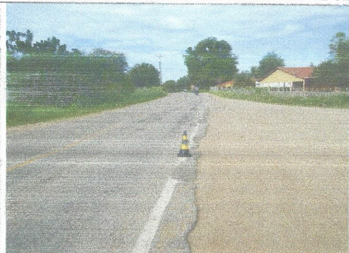
Foto 01 – Marco 01 – Encravado na margem esquerda da CE 358, sentido Tabuleiro a Limoeiro na localidade de Córrego de Areia, vista para Tabuleiro.
