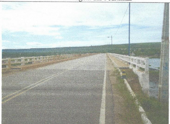
Foto 05 – Marco 03 – Situado no meio Fio do início da Ponte sobre o Rio Quixeré na localidade de Várzea do Cobra – sentido sitio Cabeça Preta.
