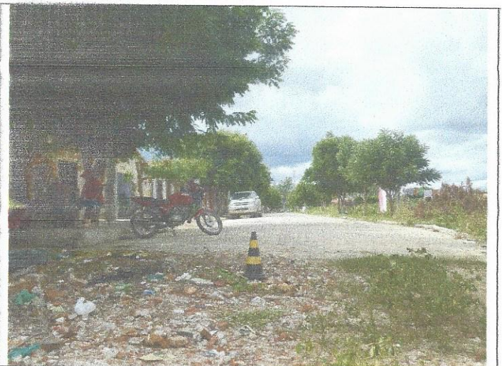
Foto 14 - Marco 07 – Vista para a Rua Maria Tercilia Nogueira, casa 99 (inclusive), fim do pavimento.
