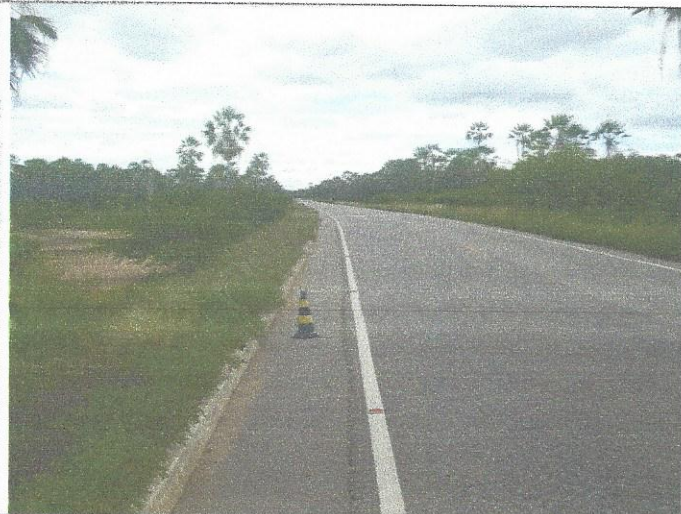
Foto 08 – Marco 04 – Encravado na margem esquerda da CE 377, sentido Limoeiro a Quixeré nas proximidades do Motel a dois (Inclusive), vista para Quixeré.
